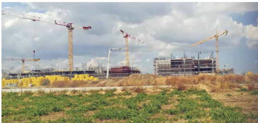
L'ospedale San Cataldo in costruzione
