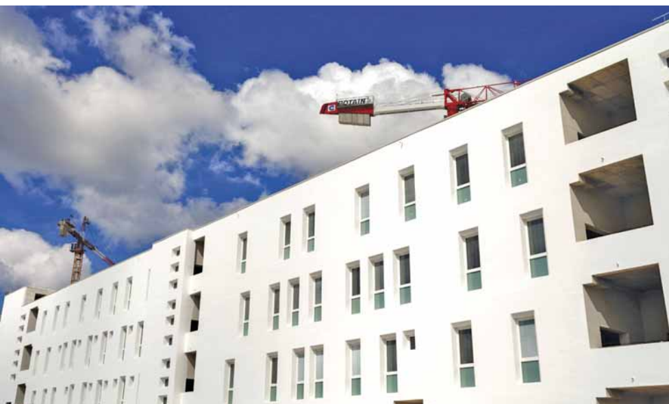
Il cantiere dell'ospedale San Cataldo a Taranto
