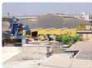
Ripristino della C.B.M.C. s.r.l.
