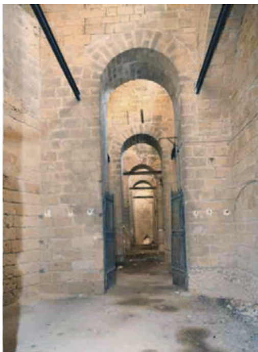
Locali murata Canale navigabile, lato nord-est (Foto MM)
