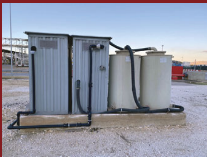
Tipico di un impianto AS + SVE di Raffineria
