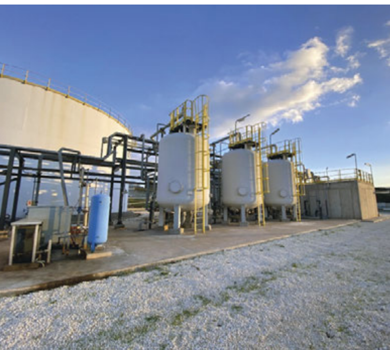
Sopra: impianto Well Point – Sbarramento Idraulico n. 6. A sinistra: impianto TAF (Trattamento Acque Falda)
