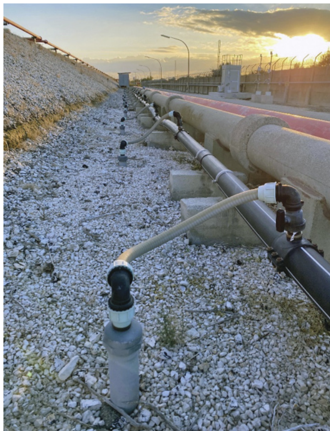
Sopra: impianto Well Point – Sbarramento Idraulico n. 6. A sinistra: impianto TAF (Trattamento Acque Falda)
